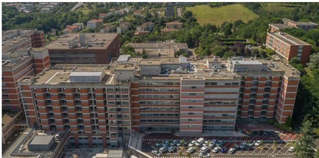
Rénovation de l'hôpital de Rangueil - Toulouse
