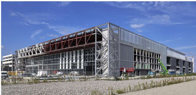
Chantier d'équipement électrique du nouveau parc des expositions - Toulouse
