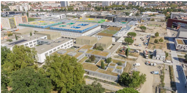
Rénovation et agrandissement de l'université Jean-Jaurès - Toulouse
